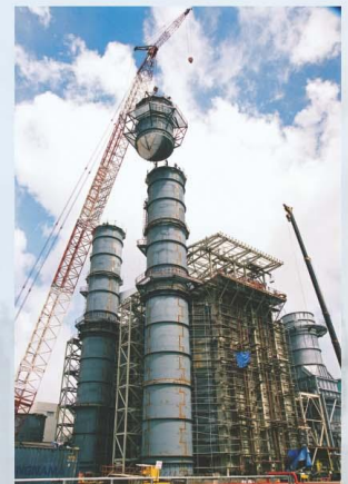
Lắp thiết bị ống khói nhà máy nhiệt điện Nhơn Trạch 1. Installation of equipment for a chimney – Nhon Trach 1 Thermal Power Plant.
