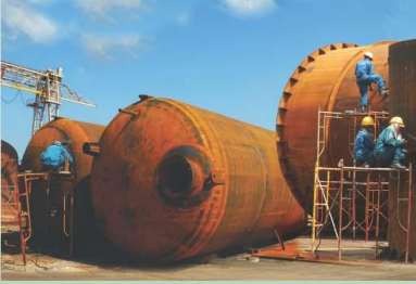
Chế tạo bồn áp lực. Fabrication, erection of pressure vessels.
