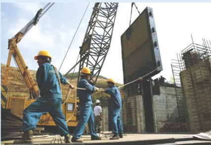
Chế tạo, lắp đặt van phẳng cho các nhà máy thủy điện Hàm Thuận. Fabrication of flat valve equipment for Hàm Thuận Hydro Power Plant.
