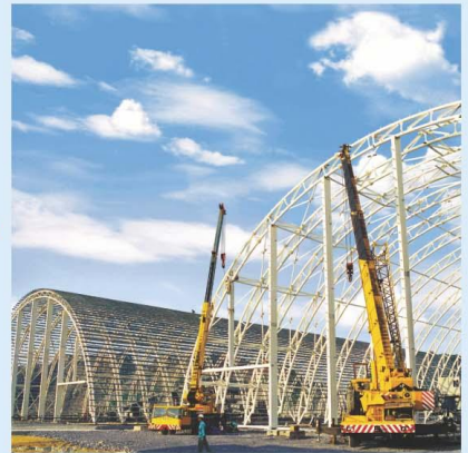
Chế tạo, lắp đặt thiết bị và kết cấu thép cho nhà máy xi măng Chìnhfon – Hải Phòng. Fabrication and installation of equipments and steel structures for Chinhfon Cement Plant Hai Phong Province.
