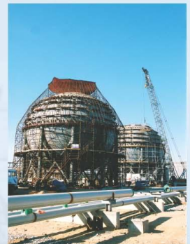
Lắp đặt bồn cầu dung tích 3794m 3 cho nhà máy lọc dầu, Dung Quất. Installation of 3794 m 3 spherical tank for Dung Quat Oil Refinery Plant.
