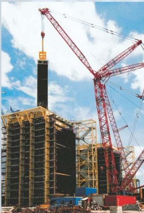
Lắp đặt Module lò thu hồi nhiệt nhà máy nhiệt điện Phú Mỹ 2.2. Lifting up HRSG modules for Phu My 2.2 Thermal Power Plant.
