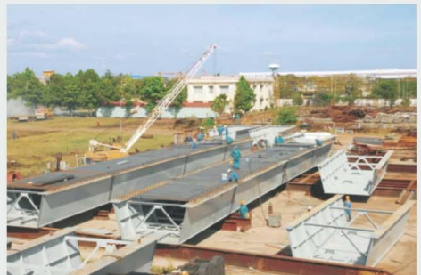
Chế tạo cầu vượt xa lộ Hà Nội Thủ Đức - Hồ Chí Minh. Fabrication of steel flyover in Ha Noi Highway – Thu Duc – Ho Chi Minh City.
