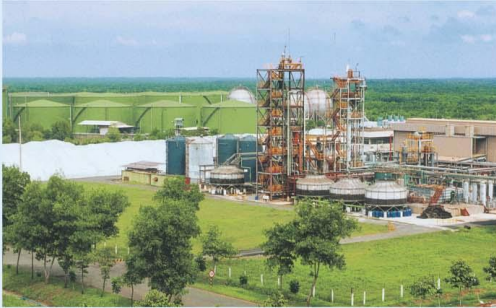
Lắp đặt thiết bị khu chế xuất thực phẩm Vedan. Installation of equipments for Food Exporting and Processing Zone.
