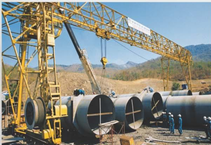
Chế tạo đường ống áp lực cho nhà máy thủy điện Đại Ninh. Fabrication of penstocks for Dai Ninh Hydro Power Plant.
