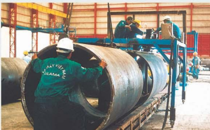
Hàn tự động ống thép. Apply auto welding on steel pipe.
