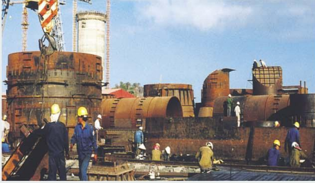
Chế tạo thiết bị và kết cấu thép nhà máy xi măng Sao Mai - Kiên Giang. Fabrication of equipments and steel structures for Sao Mai Cement Plant, Kiên Giang Province.
