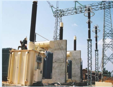
Lắp đặt máy biến thế 500kV Phú Lâm - Hồ Chí Minh.
