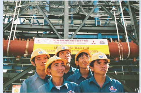
Lắp đặt bao hơi nặng 154 tấn-Nhiệt điện Ô Môn. Lifting up a 154-ton Steam Drum-O Mon Thermal Power Plant.
