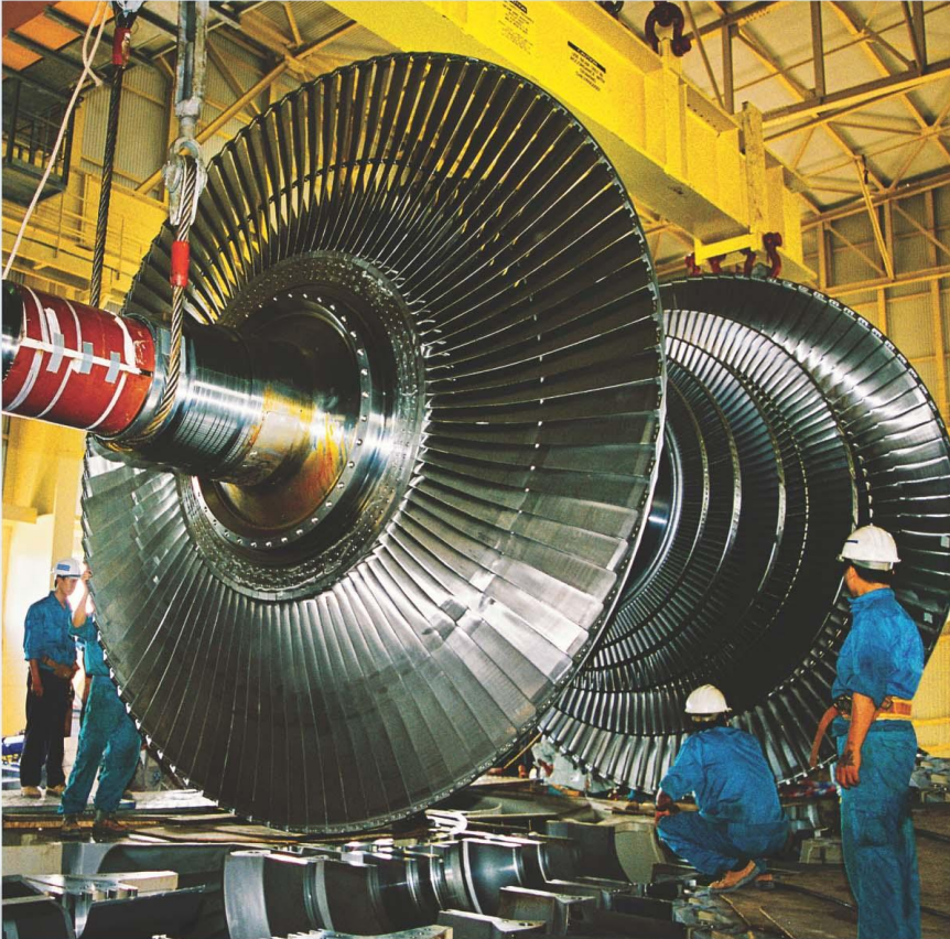
Lắp đặt Rotor - Turbine hơi nhà máy nhiệt điện Phú Mỹ 4. Installation of Rotor - Steam turbine for Phu My 4 Thermal Power Plant.
