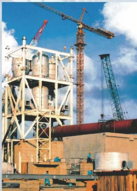
Chế tạo và lắp đặt thiết bị cho nhà máy xi măng Nghi Sơn – Thanh Hoá. Fabrication and installation of equipments Nghi Son Cement Plant – Thanh Hoa Province.
