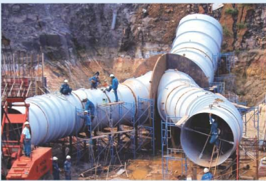
Chế tạo, lắp đặt đường ống áp lực nhà máy thủy điện Đak Glun, Bình Phước Fabrication and installation of penstock for Dak Glun Hydro Power Plant, Bình Phước Province.
