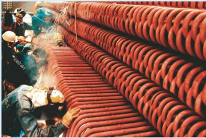
Hàn ống cao áp lò hơi nhà máy nhiệt điện Phú Mỹ 1. Welding pressure piping for boiler – Phu My 1 Thermal Power Plant.
