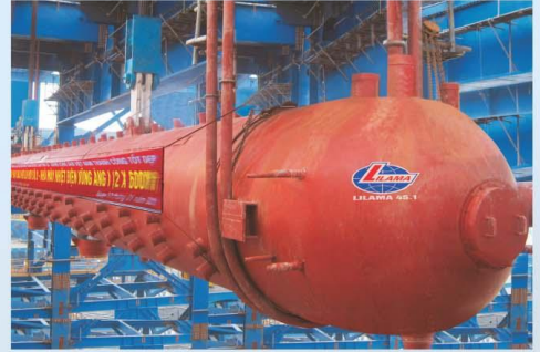
Lắp đặt bao hơi nặng 320 tấn Nhiệt điện Vũng Áng 1. Lifting up a 320-ton Steam Drum by wire jacks Vung Ang 1 Thermal Power Plant.
