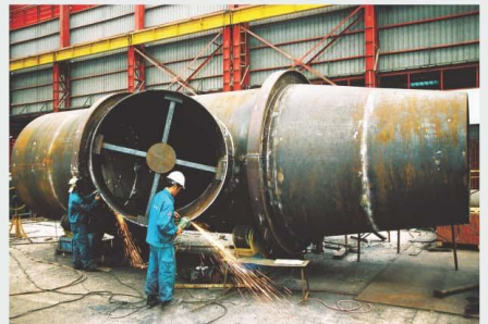
Chế tạo đường ống nước làm mát tuần hoàn cho nhà máy nhiệt điện Ô Môn - Cần Thơ. Fabrication of Circular Water pipe for O Mon Thermal Power Plant – Can Tho Province.
