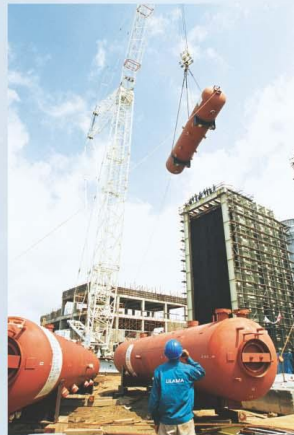
Lắp đặt bao hơi nặng 70 tấn - Nhiệt điện Nhơn Trạch 1. Lifting up a 70-ton Steam Drum – Nhon Trach 1 Thermal Power Plant.
