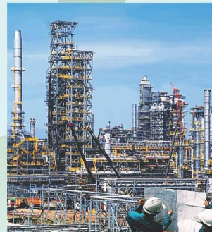
Lắp đặt thiết bị các nhà máy lọc dầu, kho chứa, trạm phân phối và đường ống dẫn khí. Installation of equipments for oil refinery plants, terminal, distribution station and pipeline.
