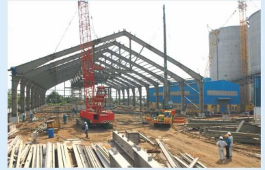
Chế tạo và lắp đặt thiết bị cho trạm nghiền – Nhà máy xi măng Hiệp Phước. Fabrication and installation of equipments for grinding station-Hiep Phuoc Cement Plant.
