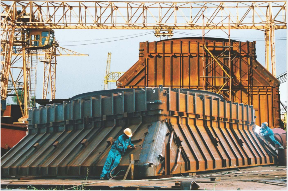
Chế tạo thiết bị lò hơi Nhà máy nhiệt điện cho MHI Nagasaki - Nhật bản Fabrication of Boiler of Power Plant for MHI Nagasaki – Japan.
