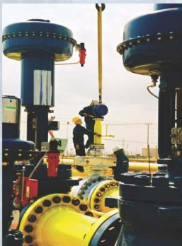
Lắp đặt trạm phân phối khí thấp áp Phú Mỹ - Gò Dầu. Installation of Phu My - Go Dau low-pressure gas distribution station.
