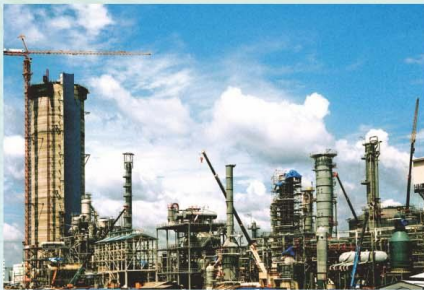
Lắp đặt thiết bị các nhà máy hóa chất. Installation of equipments for chemical plants.
