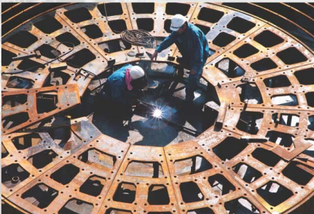
Chế tạo thiết bị Nhà máy Thủy điện. Fabrication of equipments for Hydro Power Plant.
