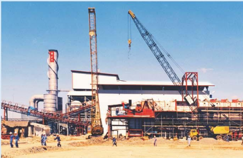
Lắp đặt thiết bị nhà máy đường Bourbon Tây Ninh. Installation of equipments for Bourbon Sugar Plant - Tay Ninh.
