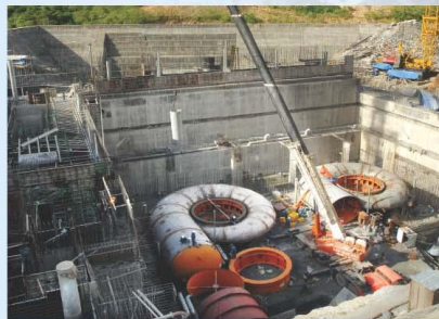
Lắp đặt buồng xoắn, dẫn nước nhà máy thủy điện Đồng Nai 3. Installation of spiral chamber guiding water for Đồng Nai 3 Hydro Power Plant.
